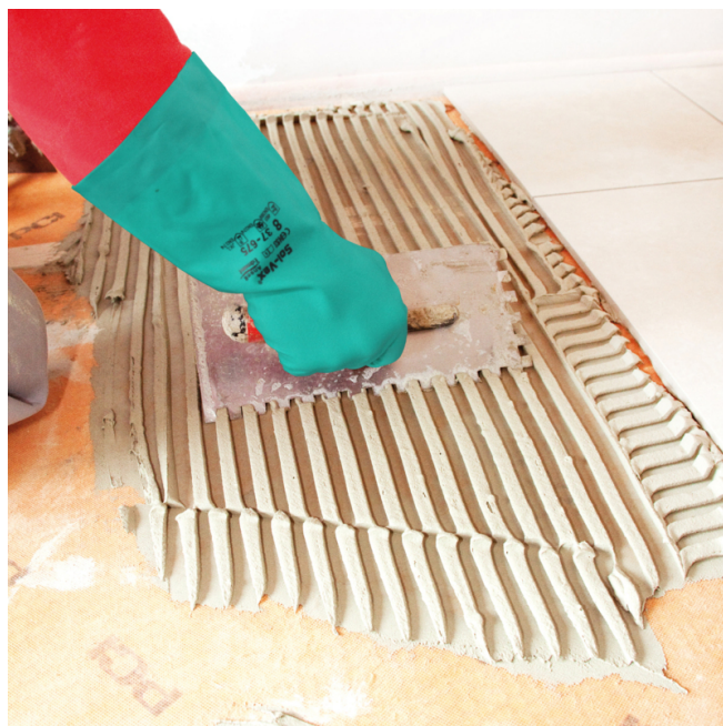
Après durcissement du lit de collage mince (respecter le temps de séchage de la colle utilisée), le carrelage peut être posé avec le mortier-colle adapté.
