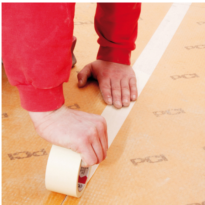
En zone sèche, surcoller les joints entre bandes avec une bande adhésive (20 mm de large).
