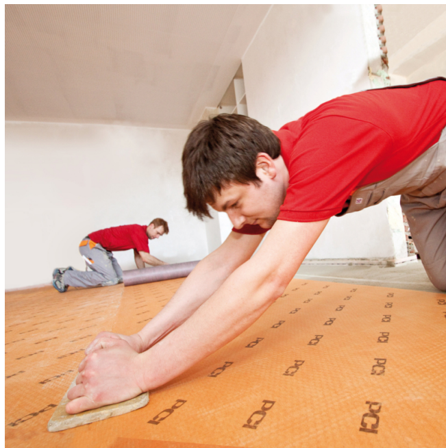
Placer les bandes de PCI Pecilastic U bout à bout (voile orange vers le haut) et presser avec une taloche.
