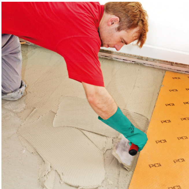
Appliquer PCI Flexmörtel S2 ou Pericol FX Rapid sur le support préparé avec un peigne U4 ou U6.
