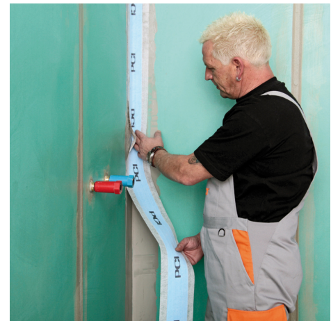
PCI Pecitape est intégré dans la couche fraîchement appliquée du matériau imperméabilisations utilisé.
