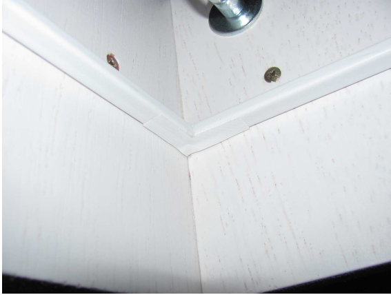
Bild 5 Dichtungsstoß
