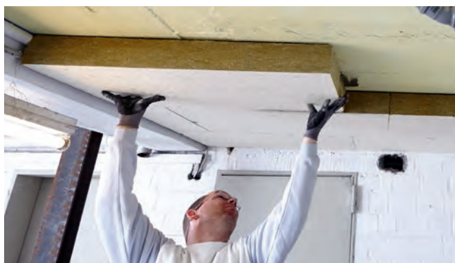
Die Dämmplatte ist mit flächigem Druck gegen die vorbereitete Kellerdecke zu pressen und der Mörtelkleber sorgfältig einzuschwämmen.
