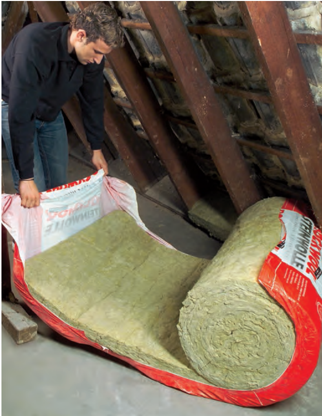
Verpackungsfolie aufreißen und Dämmfilz einfach ausrollen
