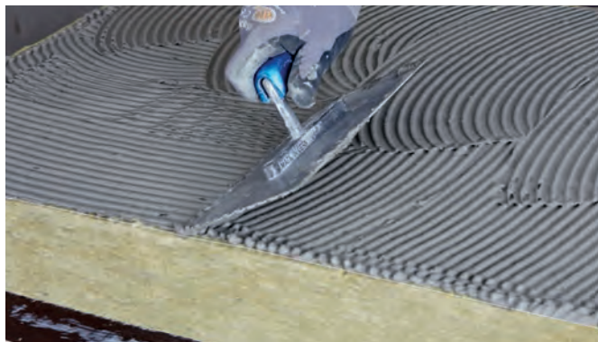
Vor der Verklebung wird der Mörtelkleber vollflächig auf die Dämmplatte aufgetragen.
