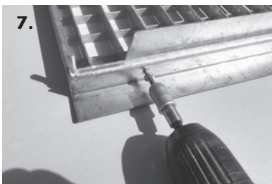
7. Adapterwinkel mit Rost verschrauben
