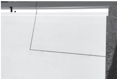
1. Wandanschlussprofile entfernen. Auszuklinkenden Bereich anzeichnen
