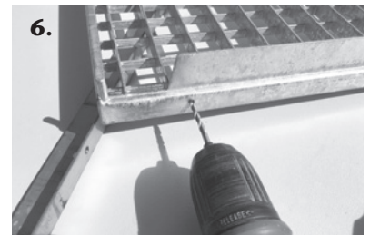
6. Mit 4 mm Bohrer vorbohren
