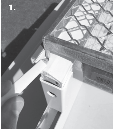
1. Verkürzter bzw. verlängerter Rost in Aufstockelement einlegen und Rostzapfen anzeichnen
