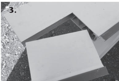
3. Wandanschlussprofil aufschieben und zuschneiden
