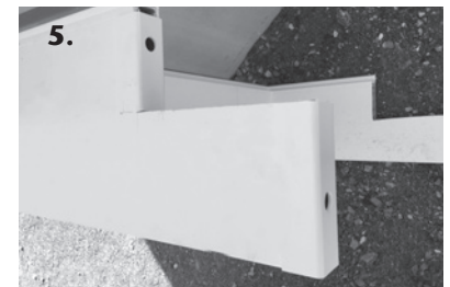
5. Wandanschlussprofil aufschieben. Nun kann das Aufstockelement montiert werden. Siehe Seite 3 und 4
