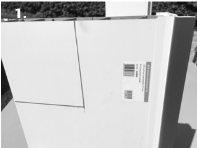
1. Wandanschlussprofile entfernen und Ausklü- nkung anzeichnen
