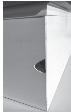
Profilkammer mit weiteren Bohrungen sowie öffnen, so dass das Verstärkungseisen entnommen werden kann
