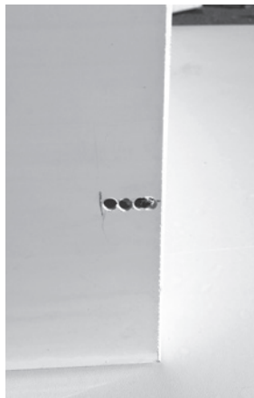
3-4 nebeneinander liegende Bohrungen setzen. Anhand der Bohrungen die Profilausrichtung ermitteln
