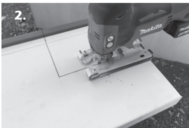
2. Ausklinkung mit Stichsäge vornehmen
