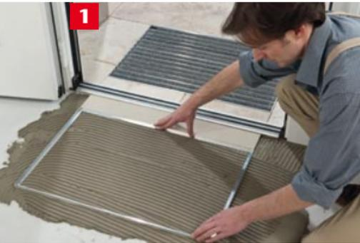
Den Winkelrahmen auf den vorbereiteten Fliesenkleber setzen, ausrichten und andrücken.
