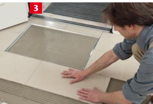
Anschließend den Bodenbelag anarbeiten. Berücksichtigen Sie eine schmale Dehnungsfuge.
