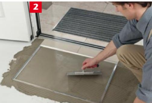
Um eine plane Auflage für die Matte herzustellen, Fliesenkleber bündig an die Rahmenunterkante anarbeiten.
