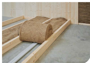
MONTAGE AU SOL
