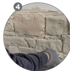
Poser le parement sur les sillons frais
