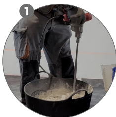
Gâcher le mortier colle
